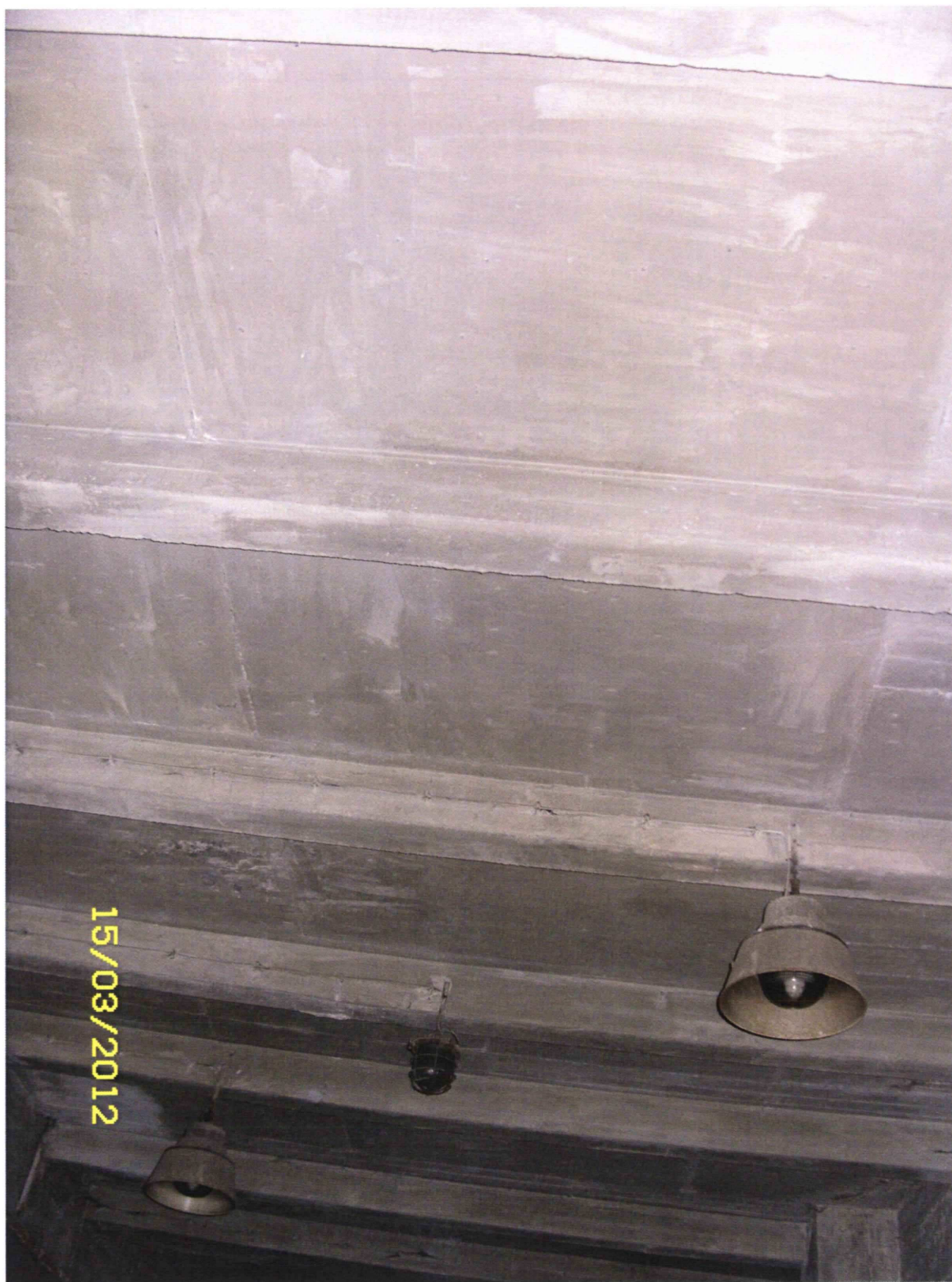
Strop nad poziomem – 5 m
