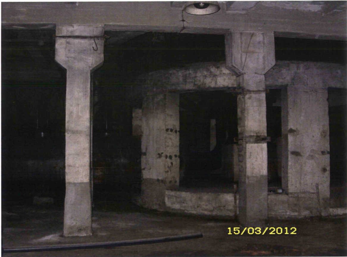
Fundament pieca na poziomie – 5 m
