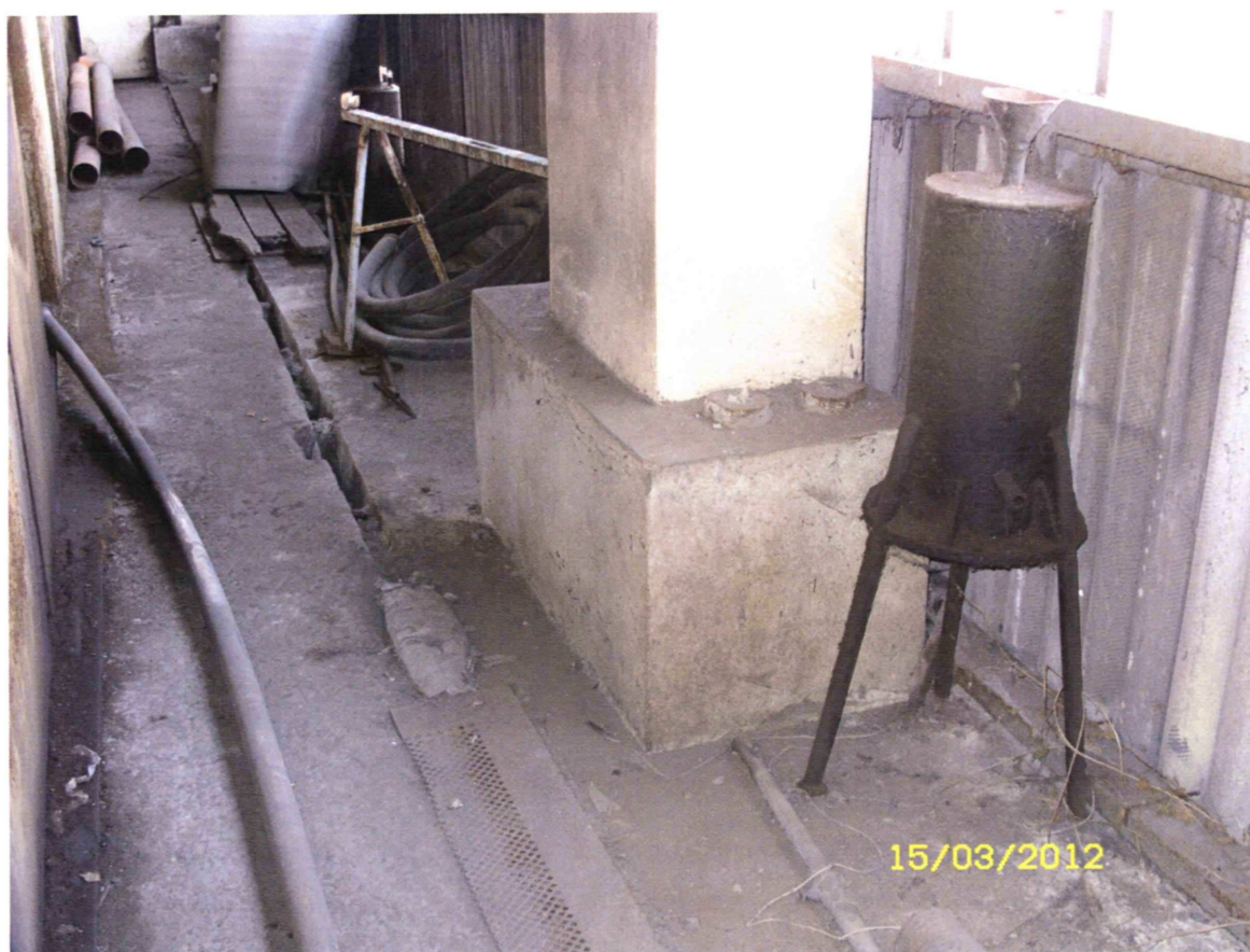
Spalarnia – stopa słupa nadziemia
