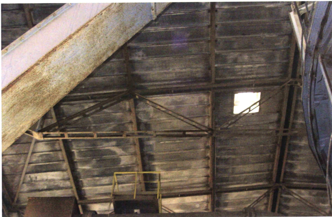
Spalarnia – wiązary i płyty korytkowe dachu
