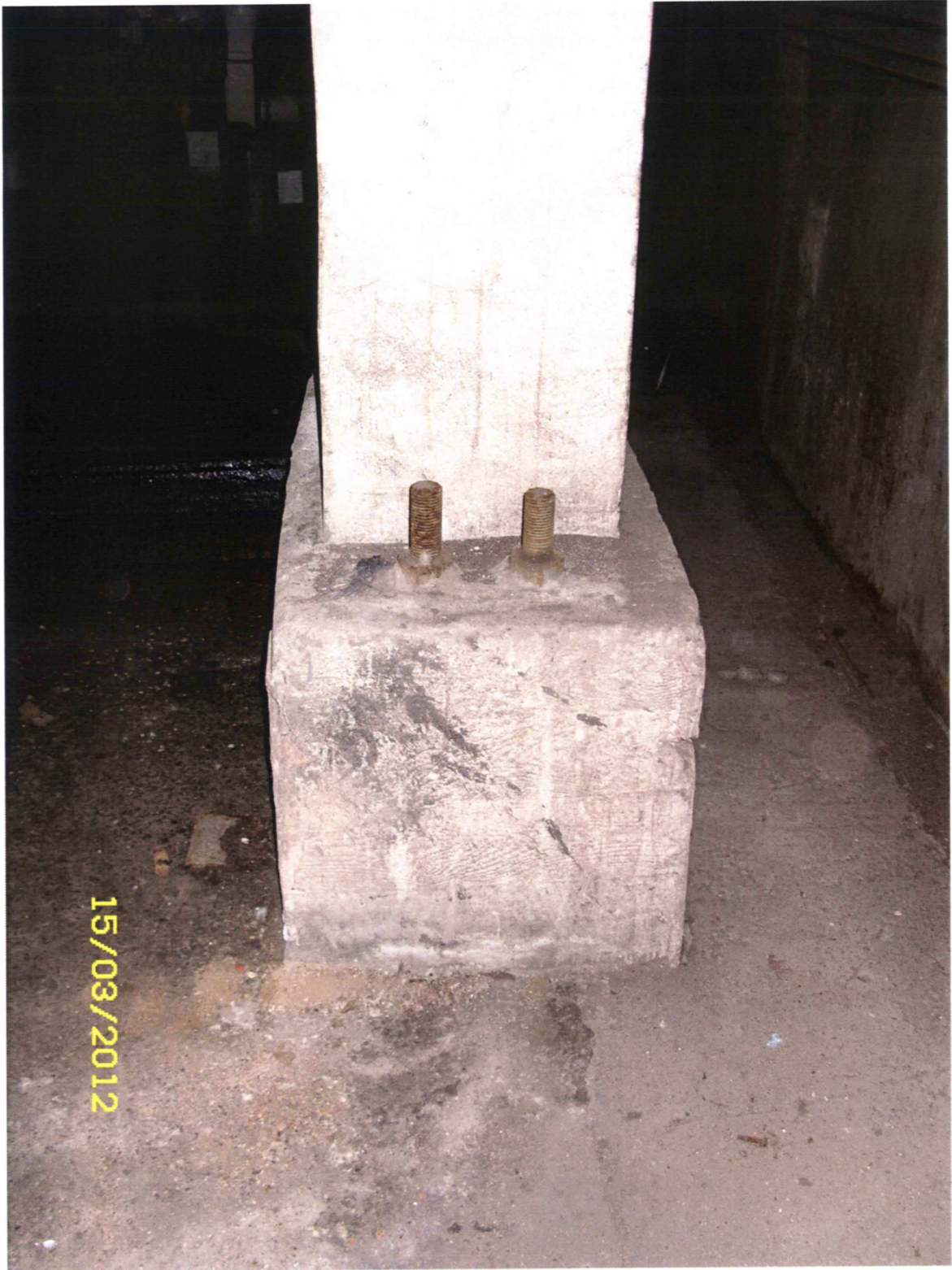
Spalarnia – stopa słupa nadziemia
