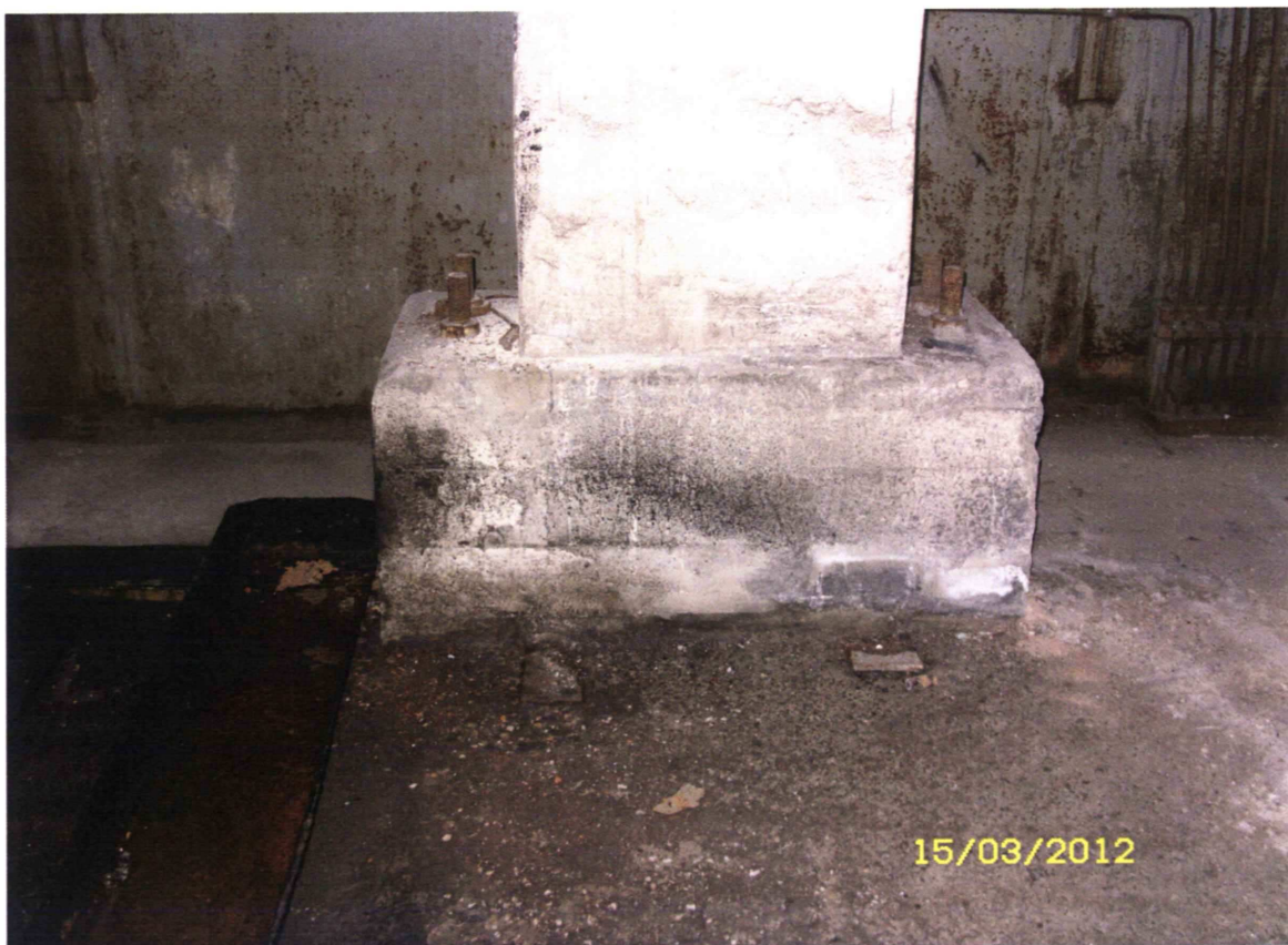
Spalarnia – stopa słupa nadziemia
