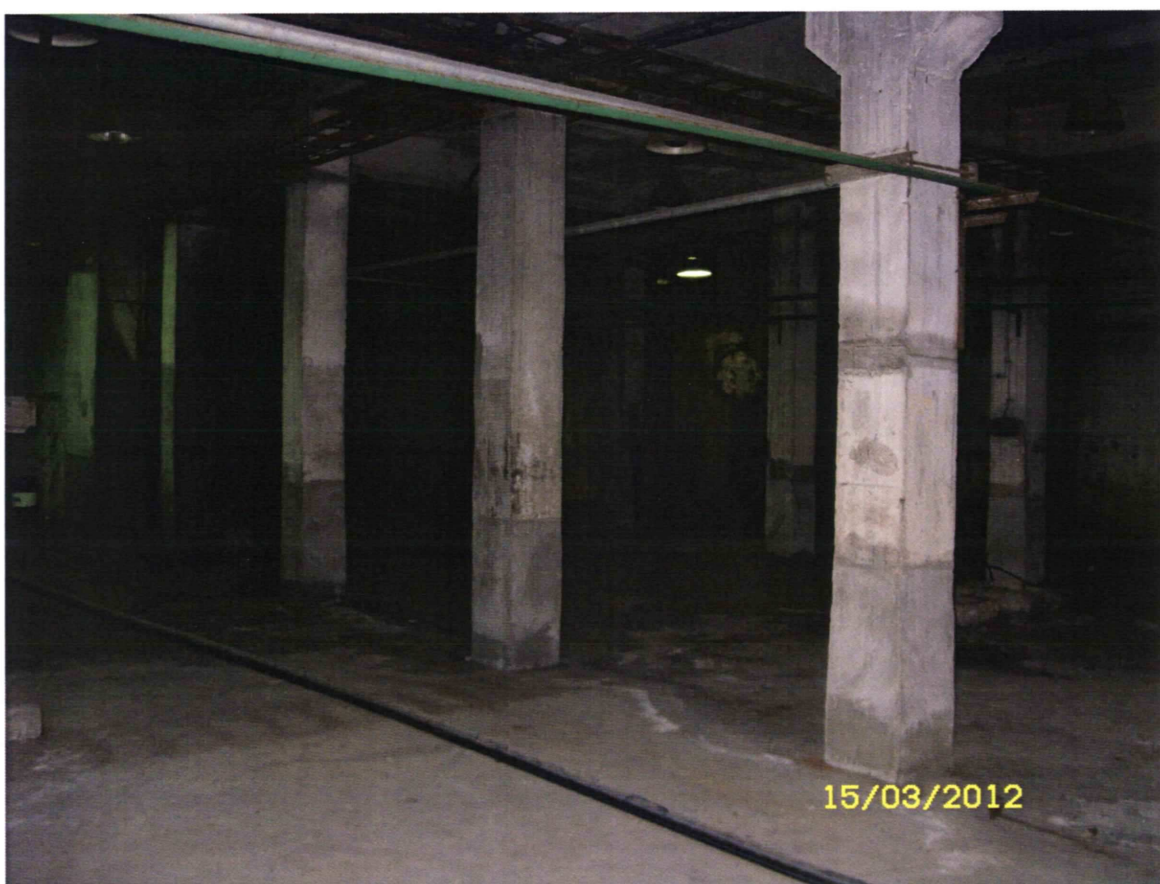
Wewnętrzne słupy na poziomie – 5 m
