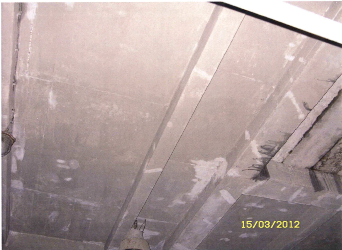
Strop nad poziomem – 5 m
